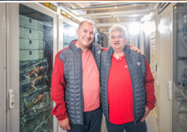
Die beiden Magenta-Betriebsräte, Michael Wobornik und Johannes Hofmeister, im Rechenzentrum in der Wiener Firmenzentrale.
