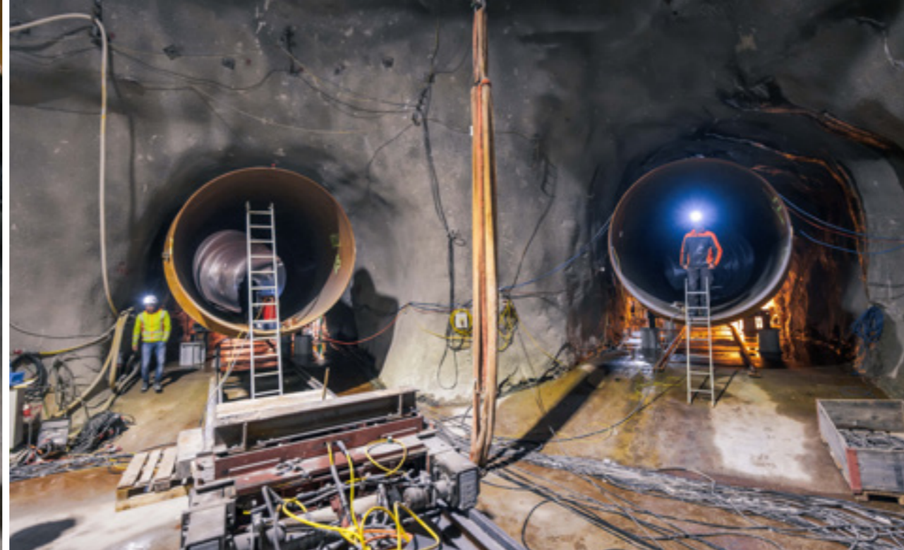
Während der Baustelle wird hier unterirdisch Gebirgswasser in einem Sammelbecken gesammelt, und Verunreinigungen werden herausgefiltert (links). Weil es im Kraftwerk später zwei Maschinensätze geben wird, wird das Wasserrohr auf zwei Rohre aufgeteilt, die später an dieser Stelle mit einem Hosenrohr verbunden werden (rechts).
