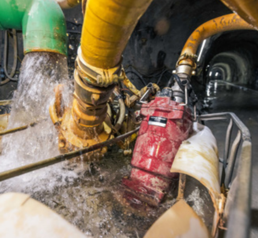
Während der Baustelle wird hier unterirdisch Gebirgswasser in einem Sammelbecken gesammelt, und Verunreinigungen werden herausgefiltert (links). Weil es im Kraftwerk später zwei Maschinensätze geben wird, wird das Wasserrohr auf zwei Rohre aufgeteilt, die später an dieser Stelle mit einem Hosenrohr verbunden werden (rechts).
