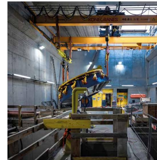
Noch hängt der Turbinenleitapparat in der Luft, in Zukunft wird er den Wasserzufluss zur Turbine steuern.
